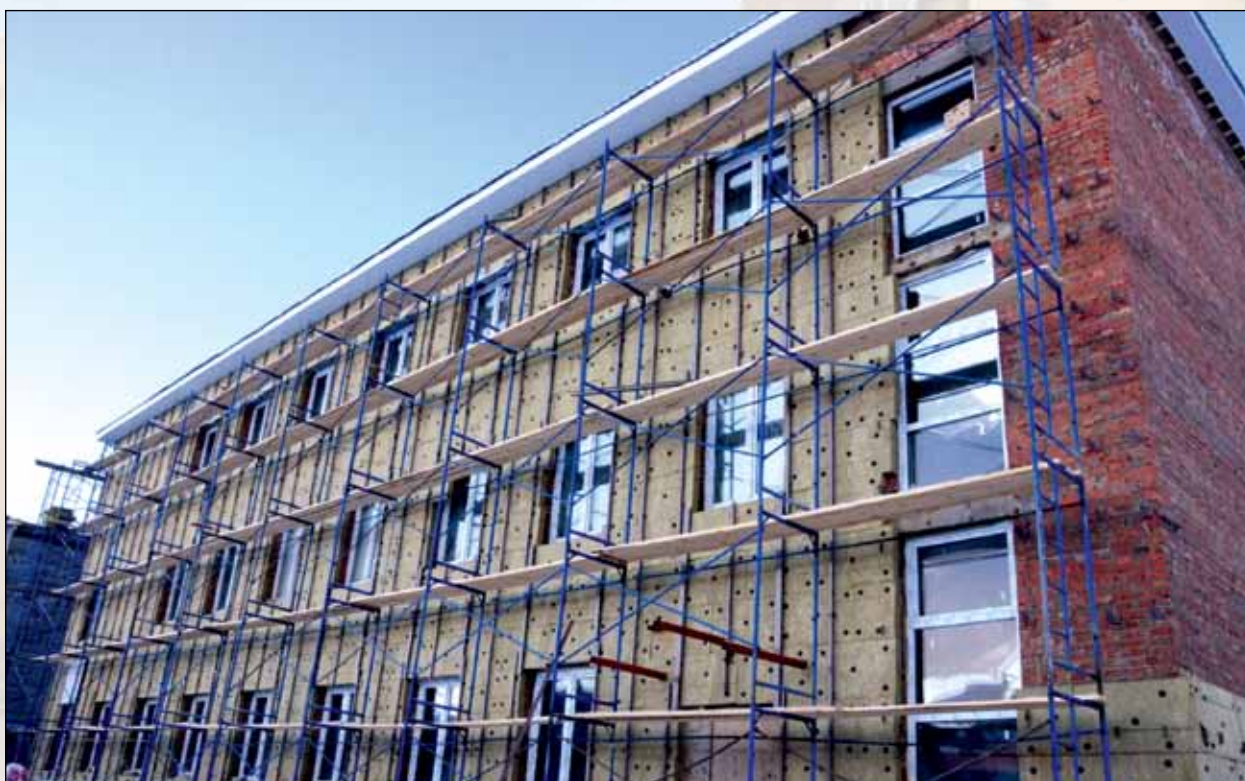
Ход работ по утеплению фасадов бытового корпуса
