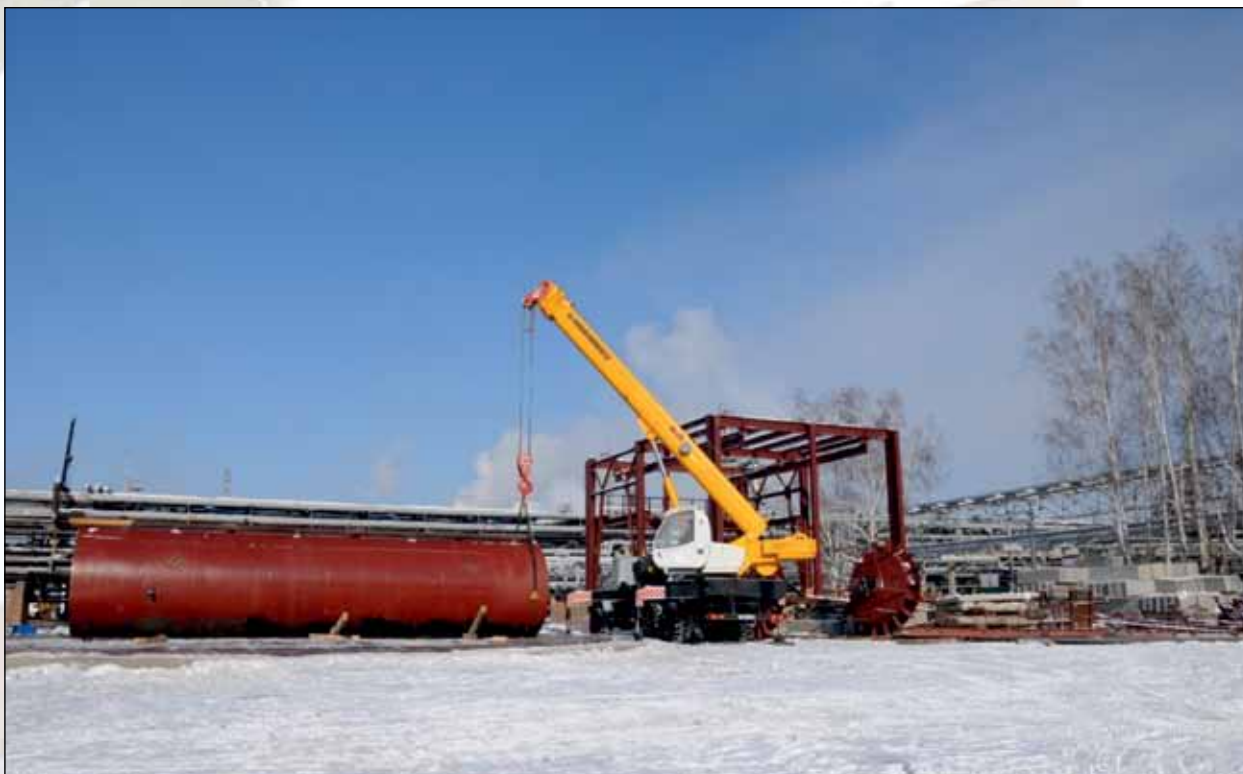
Работы по началу монтажа резервуара воды у насосной пожаротушения
