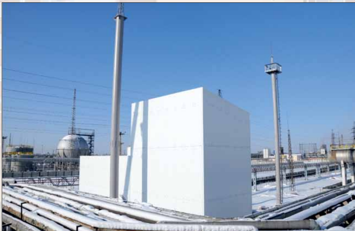
Завершенный этап устройства фасадов производственного здания
