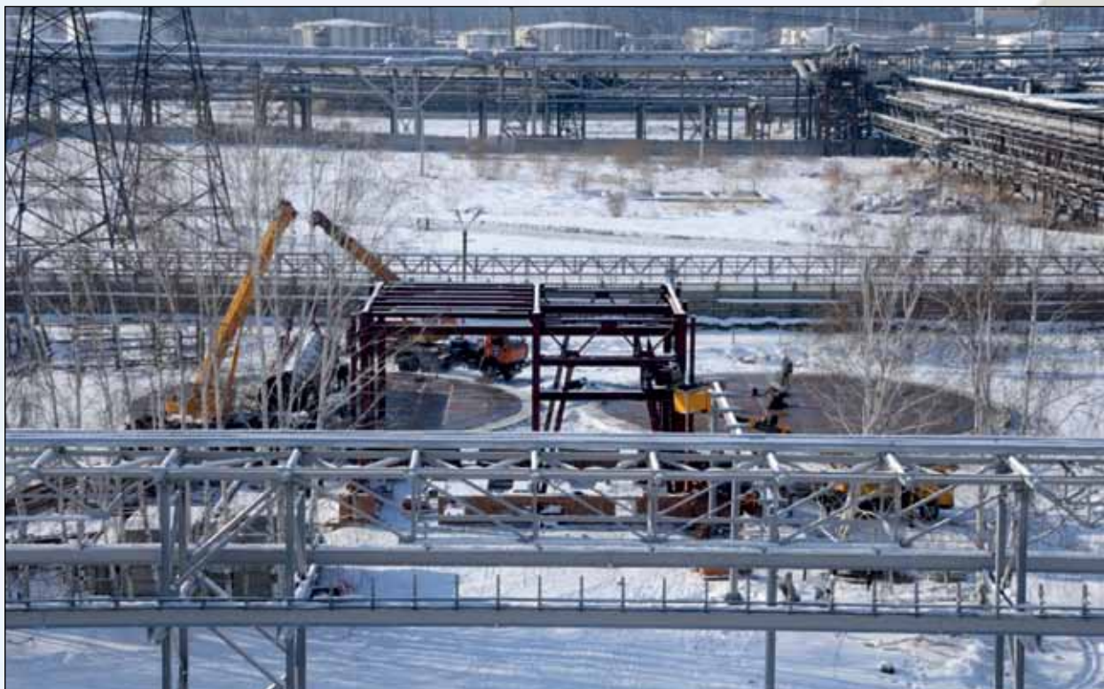
Строительство насосной пожаротушения с резервуарами воды
