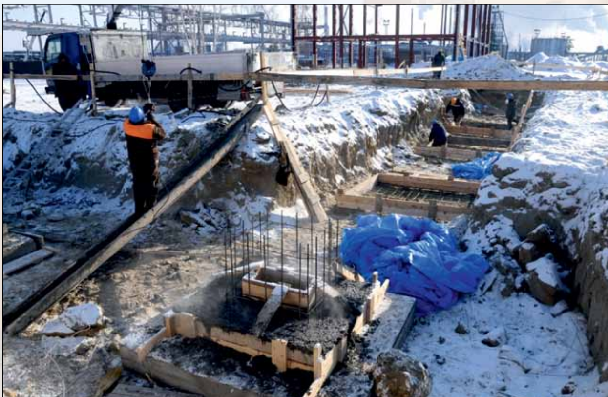
Ход работ по устройству фундаментов РТП с контроллерной
