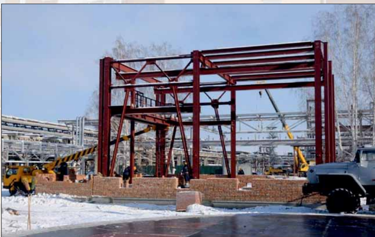
Ход строительства насосной пожаротушения
